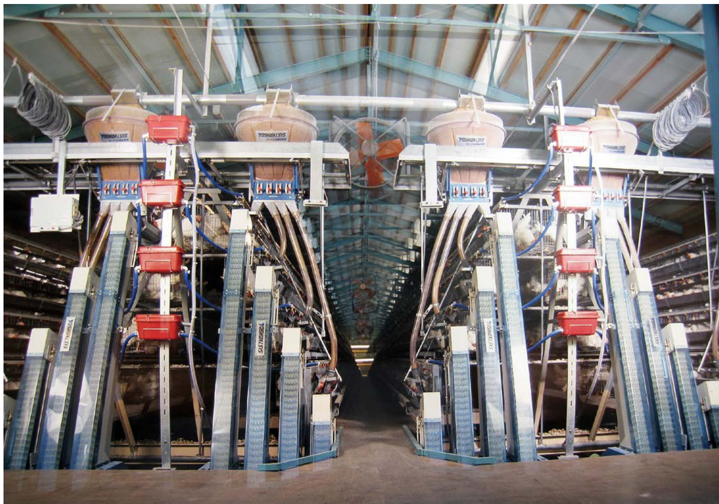
高床式4段ケージシステム
